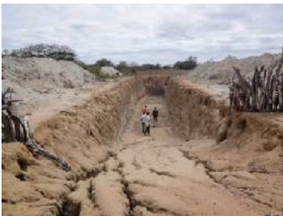
Localização do barreiro em terreno errado, de grande declive. Quando chove pouco, a água passa aos lados.
