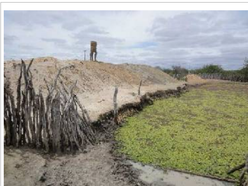
A escolha do terreno foi correto neste caso. A cada chuva que caía, a água entrava. Observe à esquerda, como o material escavado foi removido longe da parede do barreiro. Interessante: esta foto foi tirada no dia 22 de abril deste ano 2012.
