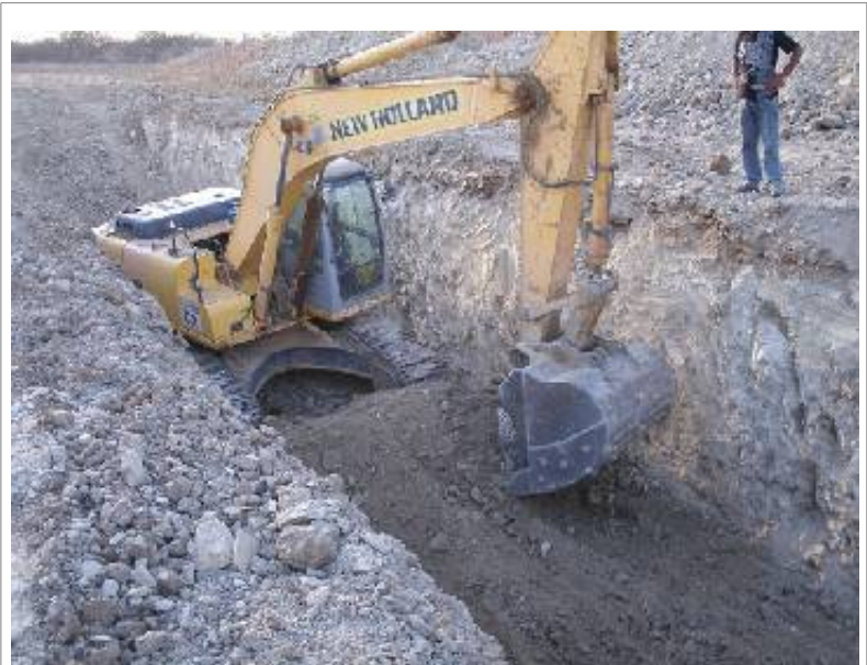
Aqui se vê o segundo passo: a máquina retira a segunda camada, até chegar à profundidade de quatro metros.
